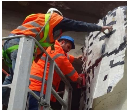
Φωτ. 2 Μαγνητική ανίχνευση οπλισμών σε μεσόβαθρο της 2 ης γέφυρας.
