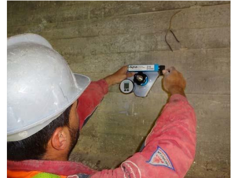
Φωτ. 3 Δοκιμή Pull-off σε δοκό της 3 ης γέφυρας.
