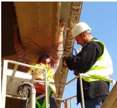
Φωτ. 1 Υπερηχοσκόπηση σε δοκό της 1 ης γέφυρας.
